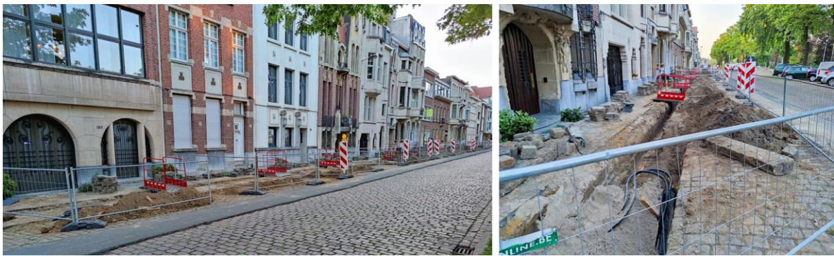
Figuur 38 – Foto's genomen in mei 2023 tonen de nutswerken die werden uitgevoerd in aanloop naar de nieuwe keerlus.
