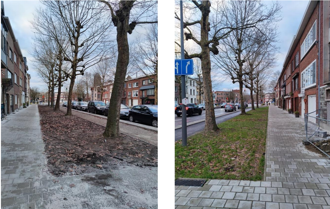
Figuur 29 – Heraangelegde Drakenhoflaan (pare en onpare zijde) waarbij alle bomen werden behouden. In de verte ziet men het kruispunt Drakenhoflaan-Boekenberglei dat deel uitmaakt van deze omgevingsvergunningaanvraag. De bomen en het straatprofiel zijn nagenoeg identiek aan die van het stuk Drakenhoflaan-Gitschotellei van deze projectaanvraag. Waarom is deze werkwijze dan niet mogelijk binnen dit project?
